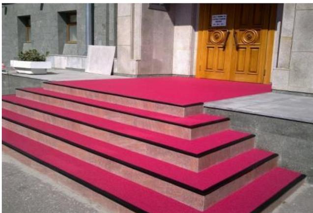
Укладывать входные зоны покрытием можно круглый год. Данный продукт не имеет сезонности, в отличие укладки плитки. Резиновое покрытие укладывается двумя способами: с помощью приклейки на специальный клей и с помощью металлических креплений (уголки, плинтуса, профили).
